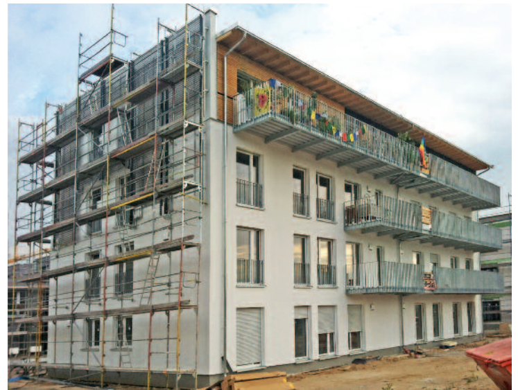
Das höchste Holzhaus Mannheims kurz vor der Fertigstellung. Die Außenhauben der freeAir-Lüftungsgeräte wurden bereits montiert, die ersten Mieter sind eingezogen. (Bild: umBau 2 Turley e. V.)
